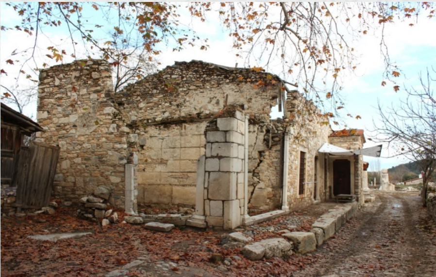
Fotoğraf 17. 1273-1292 Numaralı Parselde Yer Alan Dükkanların Günümüzdeki Durumu
