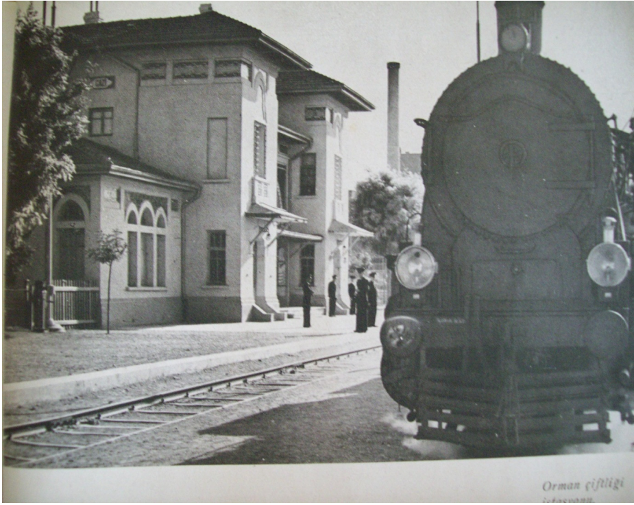
Orman Çiftliği istasyon binası
