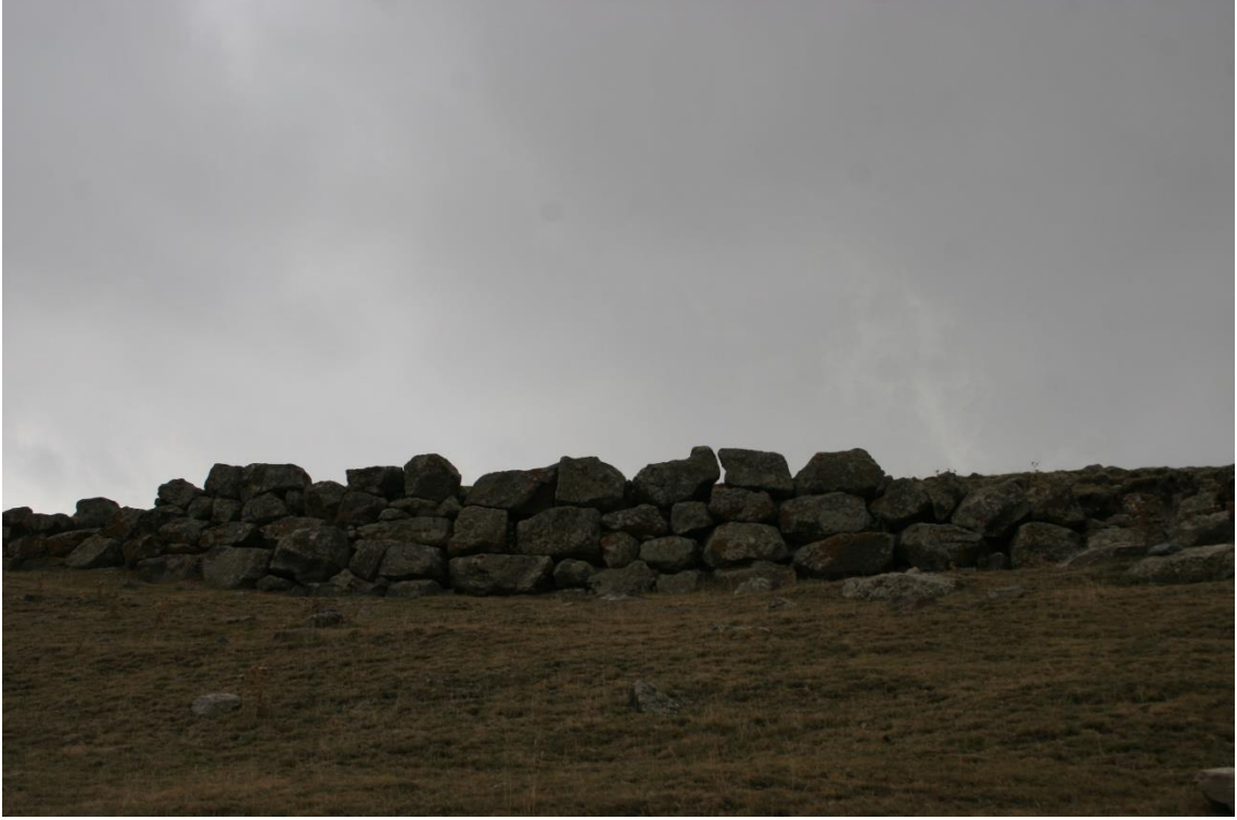
Foto 3: Yağlıca Kalesi Sur Duvarları
