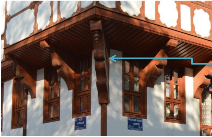
Resim 11: Evin Çıkmasını Taşıyan Elbelindelerden Genel Görünüm
