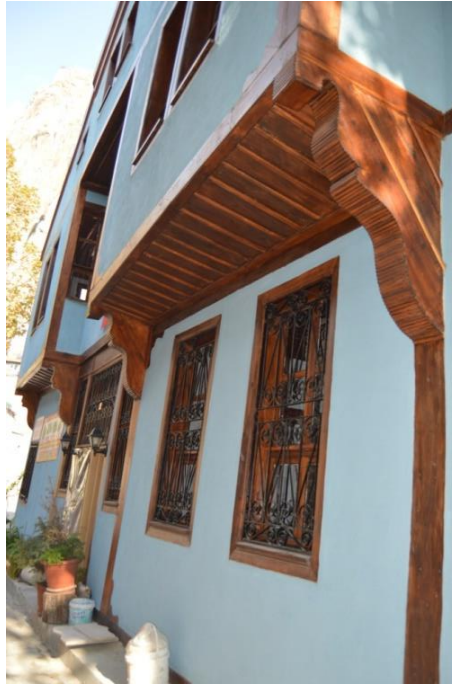
Resim 7: Evin Çıkmalarını Taşıyan Elibelindelerden Genel Görünüm
