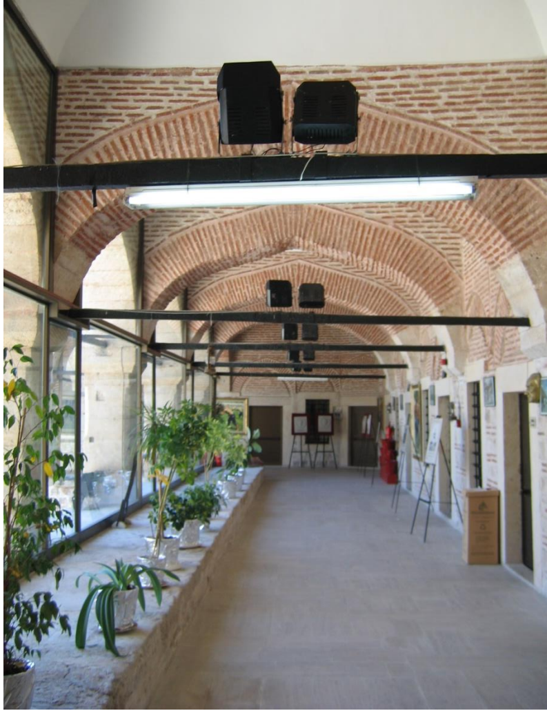
Fotoğraf 12: Hanın Üst Katındaki Revaklı Geçit
