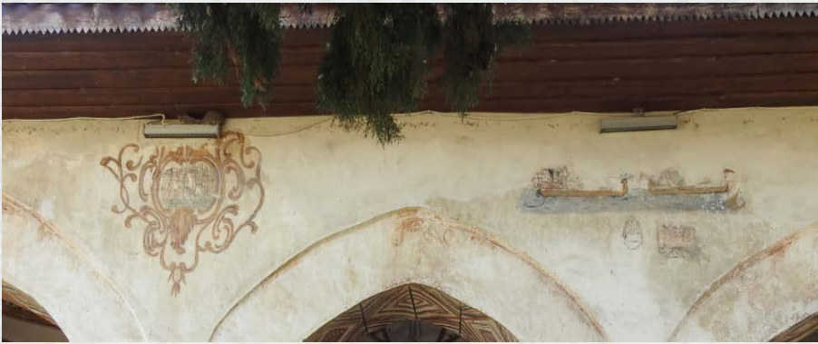
Fotoğraf 41: Caminin Kuzey Cephesi
