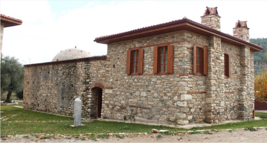
Fotoğraf 10. Selçuk Hamamı ve Ali Aydın Evi Restorasyon Sonrası Durumu
