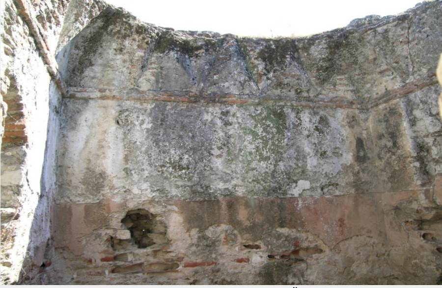
Fotoğraf 9. Selçuk Hamamı Sıcaklık Bölümü Onarım Öncesi Durumu
