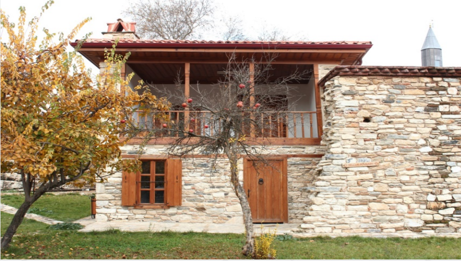
Fotoğraf 31. Ali Aydın Evi Güney Cephesi
